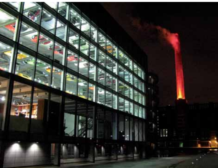
Nachtsicht auf verspiegelte Deckenuntersichten.
