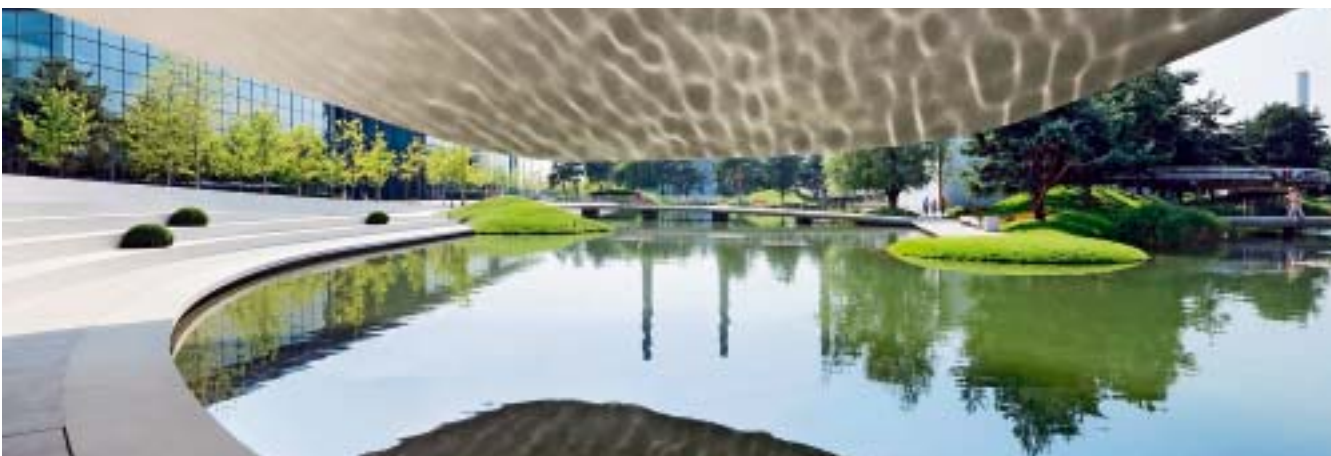
Durch die Auskrägung reflektiert das Wasser auf die Edelstahl-Bleche der Dachhaut.
